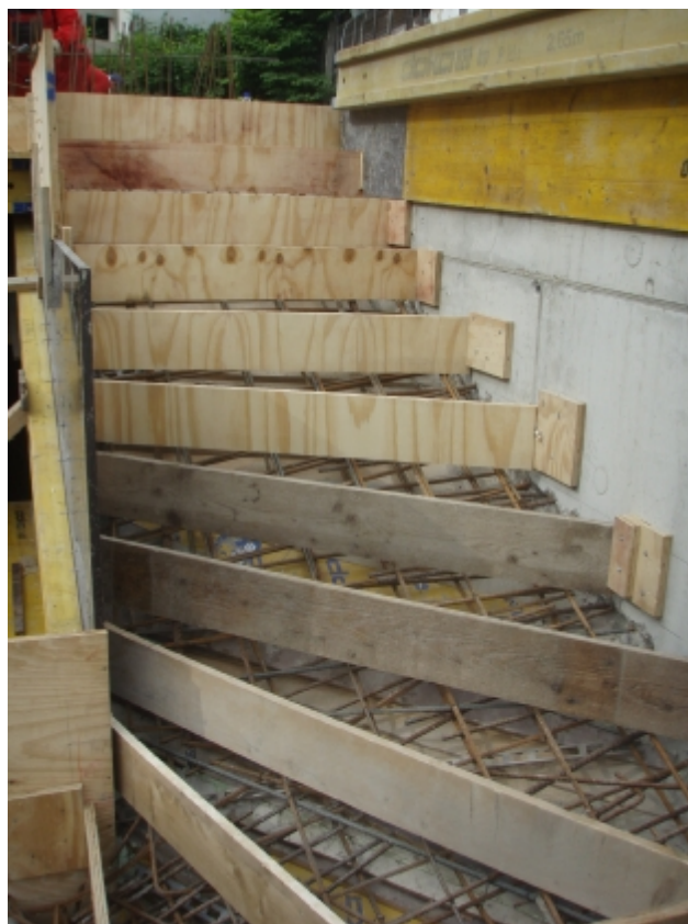
bednění a výztuž schodiště
