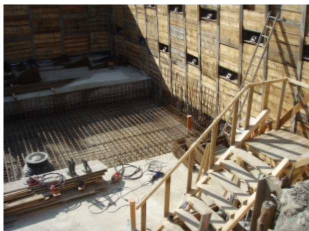
výztuž základové desky a zajištění stavební jámy
