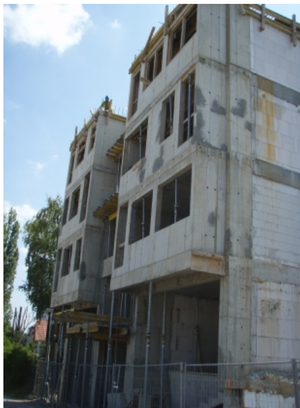
pohled na budovu
