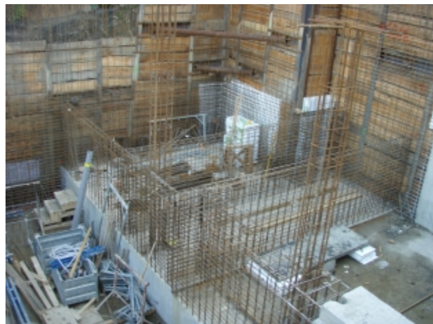
výztuž suterénních stěn
